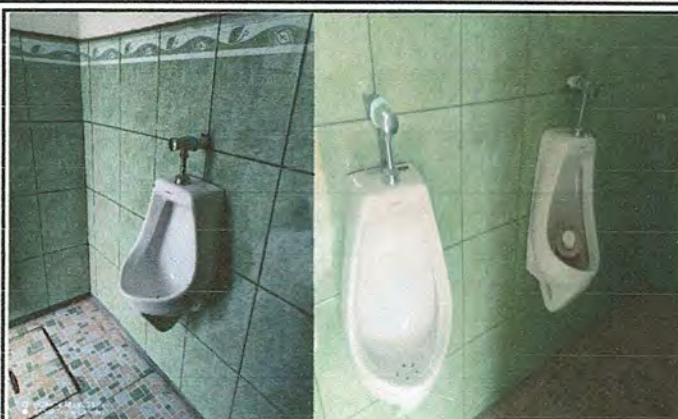
Foto 2: Mejoramiento de servicios sanitarios y sus accesorios.
