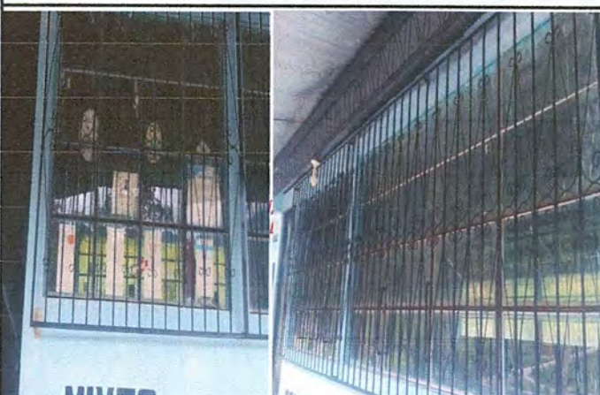
Foto 4: Mejoramiento de barandas.
