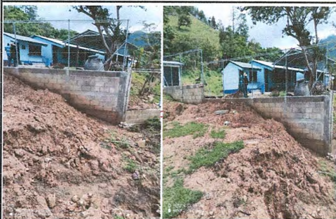
Foto 3: Mejoramiento de muro perimetral.
