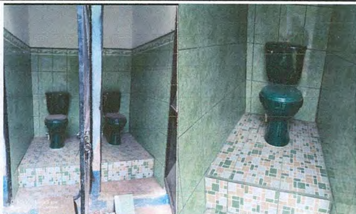
Foto 1: Mejoramiento de servicios sanitarios y sus accesorios.
